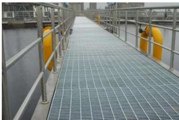
Estações de Tratamentos de Água
