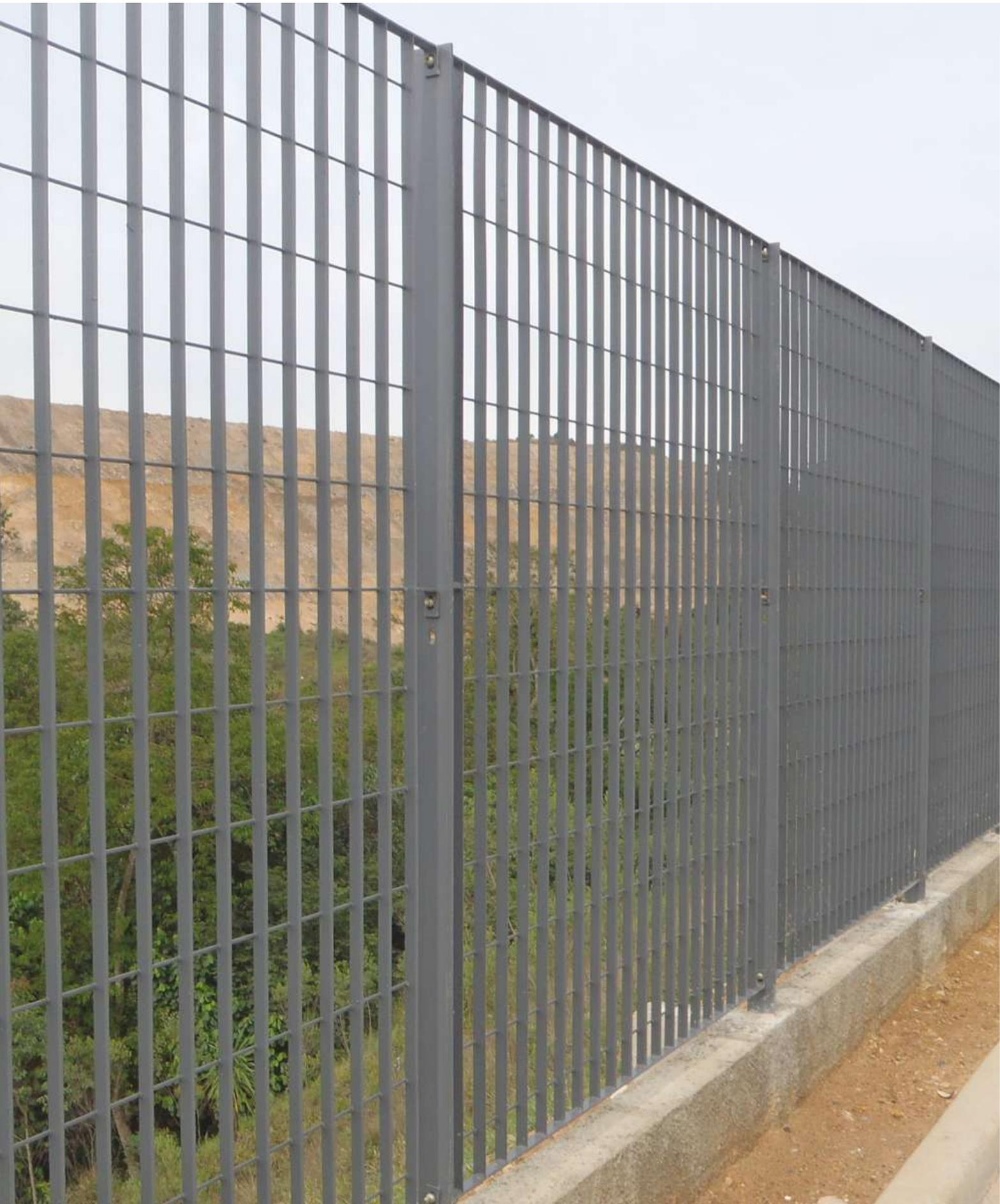
Cercamento modular em gradil soldado pelo sistema de solda por eletrodeposição composto de barras portantes verticais de secção retangular e barras de ligação horizontais de secção redonda.
