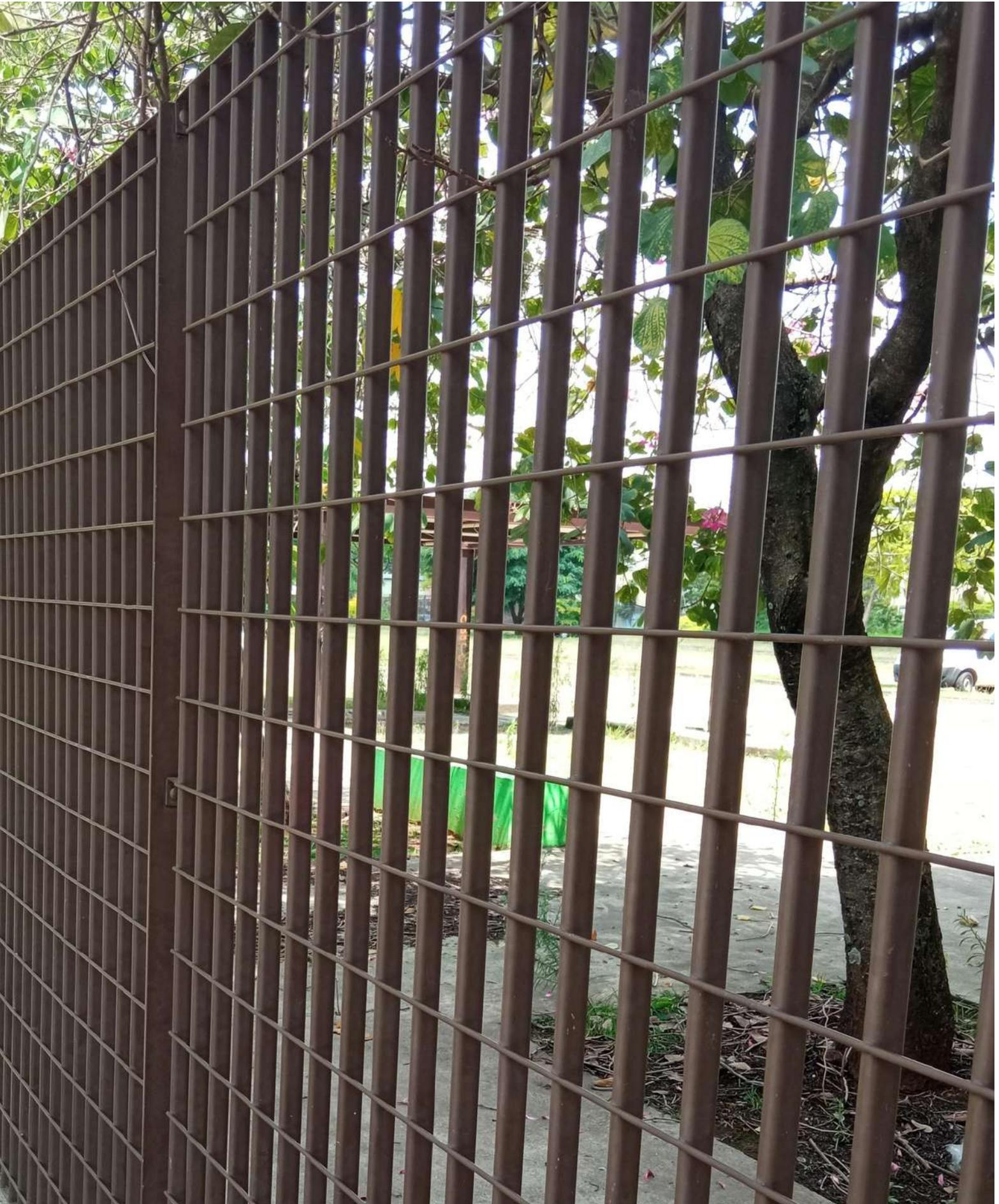
O gradil Mafergrade® Stronger é robusto e resistente é soldado pelo sistema de solda por eletrofusão e composto de barras verticais de secção tubular oblonga e barras de ligação horizontais de secção redonda.
